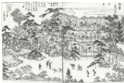
「都林泉名勝回会」巻之二円山安養寺瑞之寮「東山第一楼」 東山第一楼は、淇園らがよく集った場所の一つで、現在の円山公園のなかにあった料亭。三階で永田観鷲(ながたかかんが)が大字を描いている。当時の書画会の様子がよくわかる。
